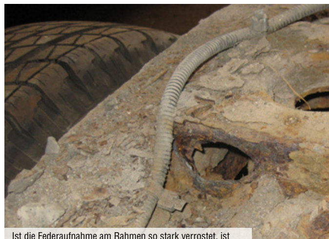
Ist die Federaufnahme am Rahmen so stark verrostet, ist eine Reparatur zwar noch möglich, aber sehr aufwändig.
